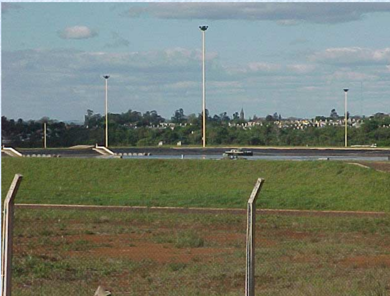
Laguna de Planta de tratamiento lindera al aeropuerto
