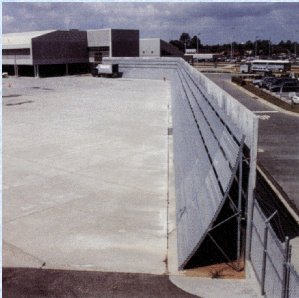
Barrera de amortiguación del ruido
