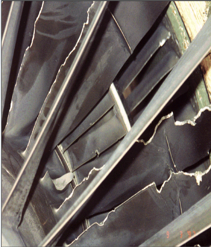
Daños FOD - Alabe
